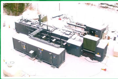
Bioboksi® Biogas plant, Qvidja Kraft AB, Parainen, Finland
