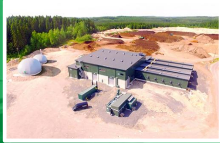
BioGTS® Biogas plant, Mustankorkea Ltd., Jyväskylä, Finland
