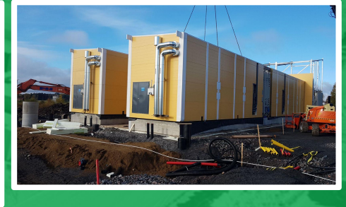
BioGTS® Biogas plant, Punkalaitumen Bioenergiaoyhtiö Ltd. Punkalaidun, Finland
