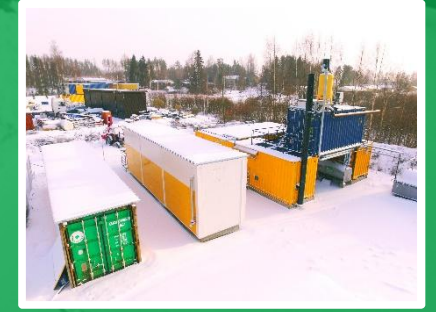
BioGTS® Biodiesel plant, BioMpower Ltd., Laukaa, Finland
