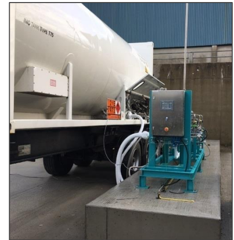
LNG satellite station design / LNG container unloading
